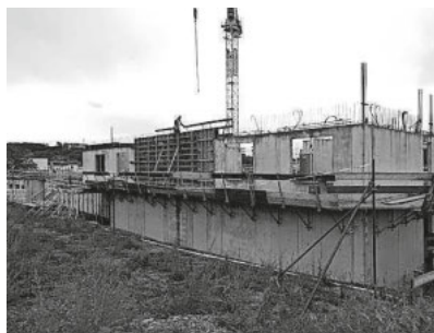
Baustelle am Sonnenstück 25.09.2020
